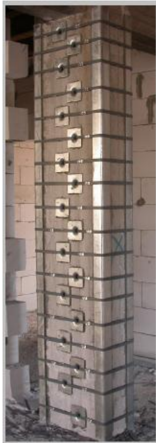
Figura 3: Disposizione a quinconce per elementi strutturali con una dimensione nettamente prevalente sull'altra.
